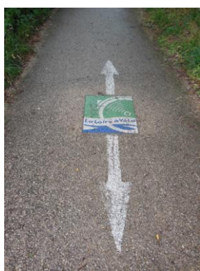
Exemples de marquage au sol. Le passage fréquent de véhicules motorisés impose un entretien régulier et rigoureux
