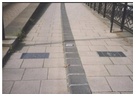
Dalles en pierres naturelles. A gauche, solution utilisée aux Pays Bas dans tous les secteurs protégés. La forme du losange est facilement reconnaissable. A droite, balisage d'un chemin piéton et d'une piste cyclable à Nantes.
