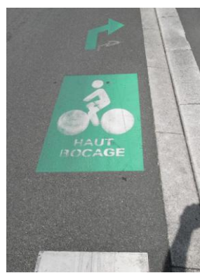
Exemples de marquage au sol. Le passage fréquent de véhicules motorisés impose un entretien régulier et rigoureux
